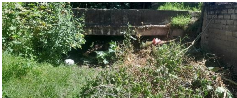
Fig. 03 Cauce Qda Chulucanas. Tramo crítico. Nótese canal de regadío que cruza la Qda y nótese la acumulación de sedimentos
