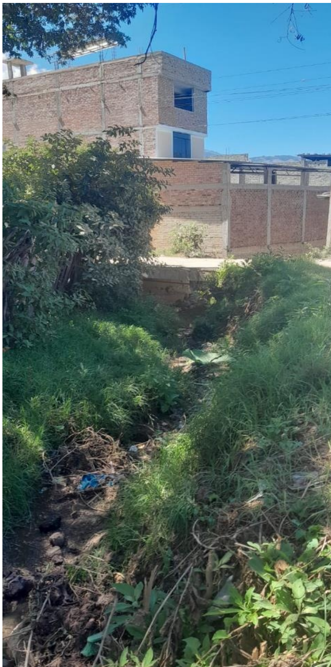
Fig. 01 Cauce Qda Chulucanas. Tramo crítico. Nótese la vivienda construida a la margen izquierda de la Qda.
